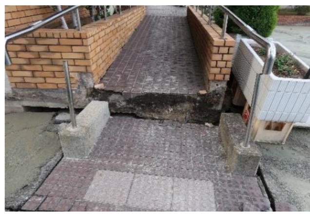
正面玄関横スロープ
