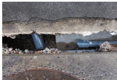
上下水配管も破損
