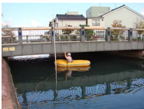
ボートによる点検
