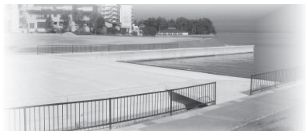
建設が進むヨットハーバー施設（和倉温泉）
