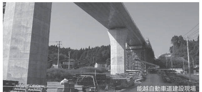
能越自動車道建設現場
