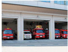
消防本部の消防・救急車両
