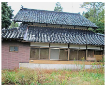
市内の空き家
