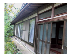
市内の空き家
