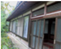
市内の空き家
