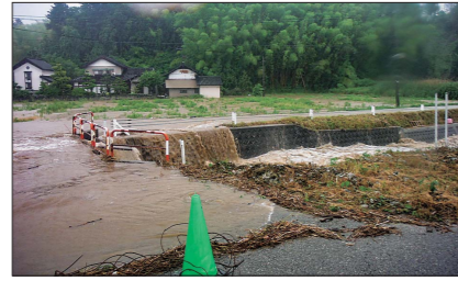
豪雨による被災状況
