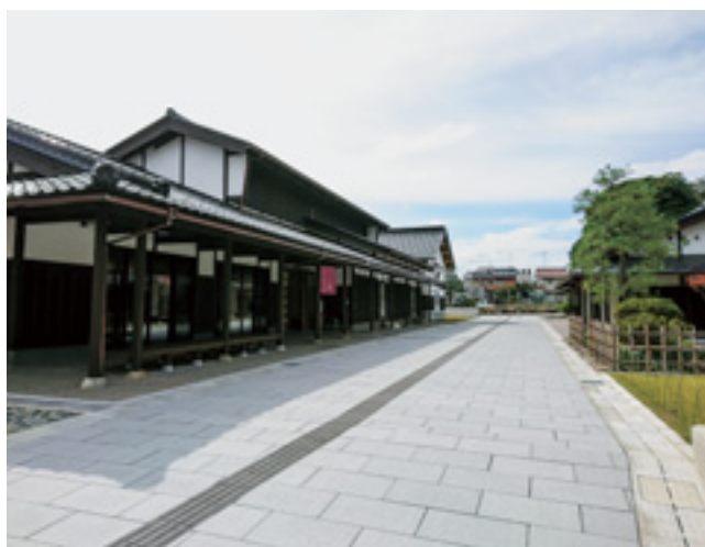
七尾市街地西地区まちづくり事業の一つとして建設された「七尾市中心街地観光交流センター」
