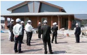
建設中ののと里山里海ミュージアム
