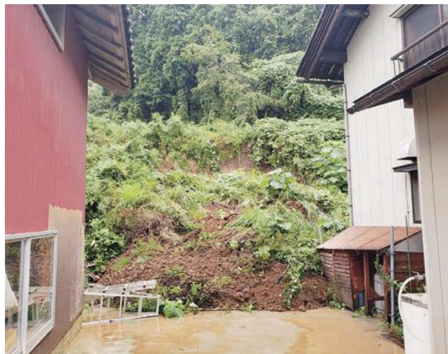
豪雨によるがけ地崩壊
