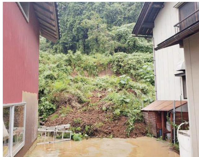
豪雨によるがけ地崩壊
