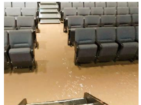
豪雨により浸水した能登演劇堂
