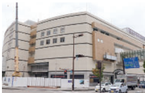
外壁工事が進むパトリア
