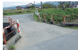
国分橋 (通称：鼠田橋)
