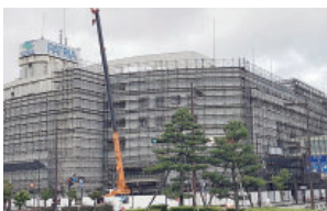
外壁改修中のパトリア
