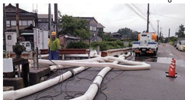
排水ポンプ車による排水作業(浜岡川)
