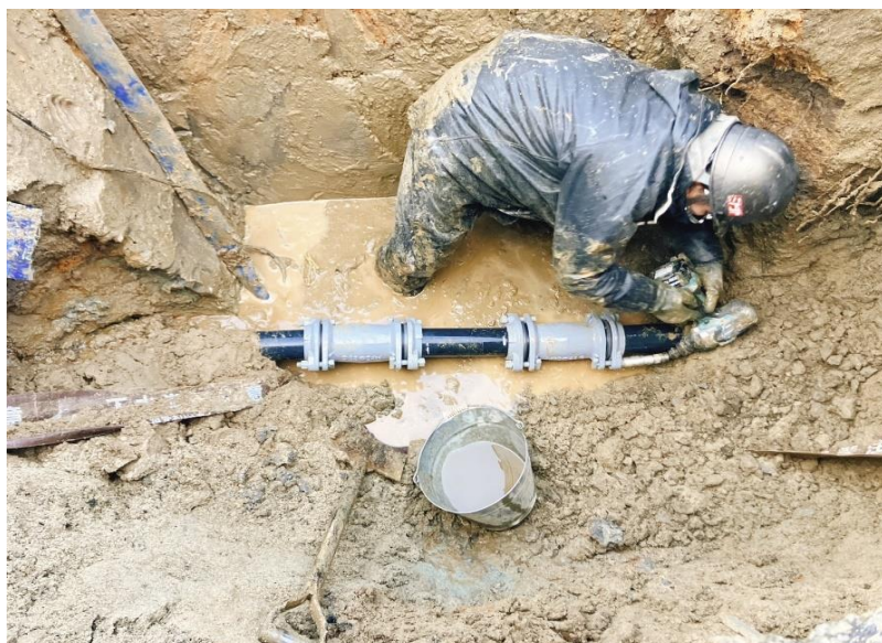
漏水箇所修繕作業
