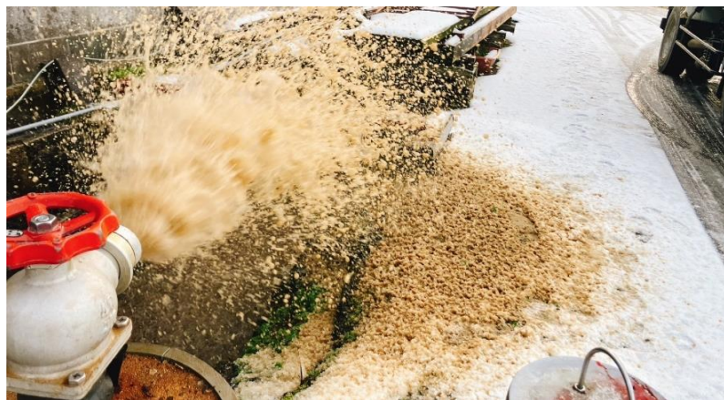
修繕後の洗管作業
