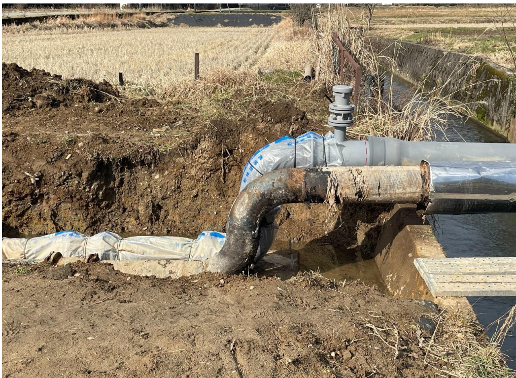
能登島須曽水管橋で県水供給管の補修を行いました。
