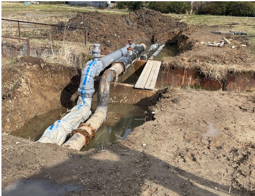
【能登島須曽水管橋】
