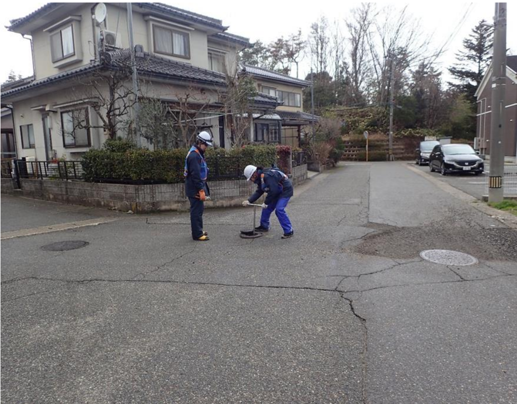
和倉町地内では、エリアごとに水道管の漏水調査を進めています (新潟市)
