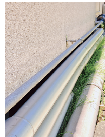
屋外でむき出しになっている水道管
