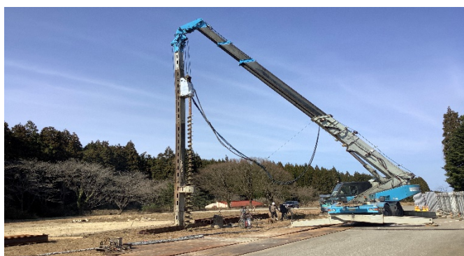
【写真①】親杭打設
