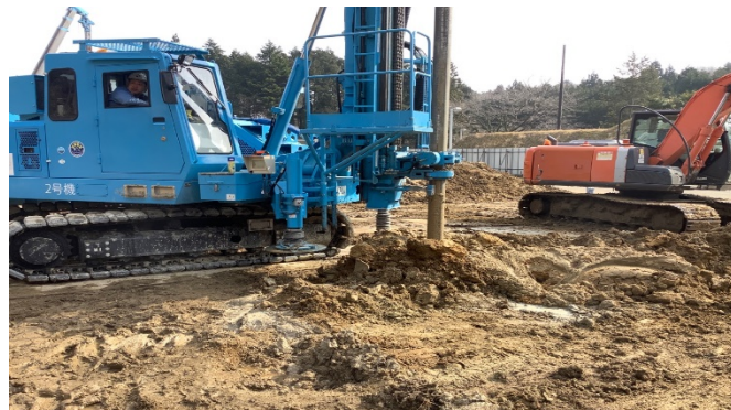
【写真④】柱状地盤改良
