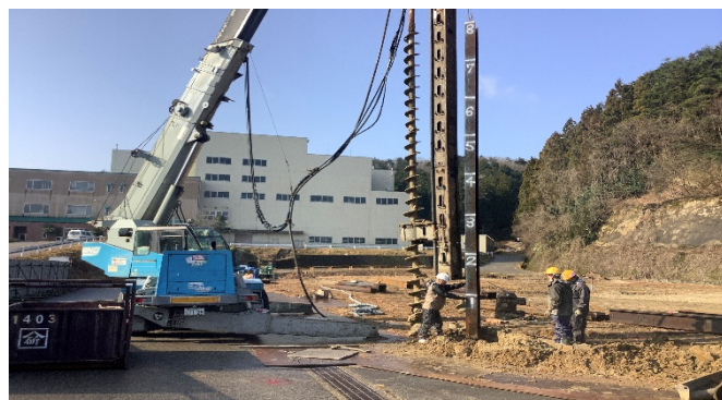
【写真②】親杭打設
