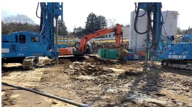
【写真③】柱状地盤改良
