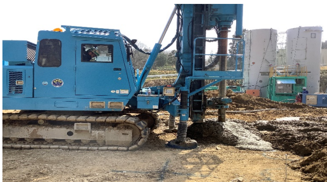
【写真①】柱状地盤改良
