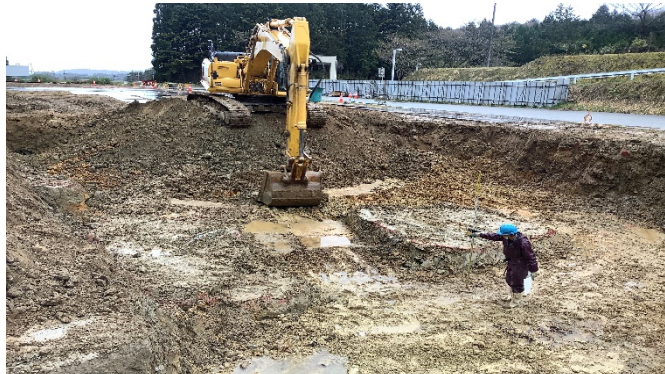
【写真④】掘削作業
