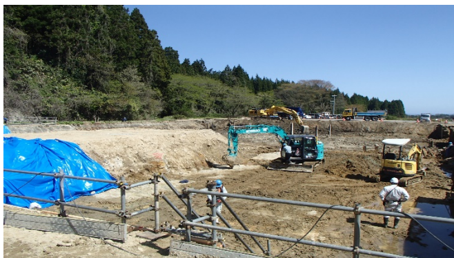
【写真③】掘削作業
