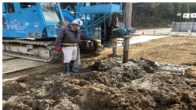
【写真②】柱状地盤改良
