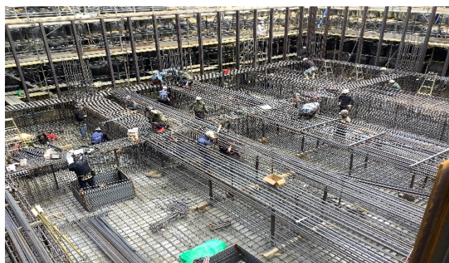
【写真③】鉄筋組み立て作業
