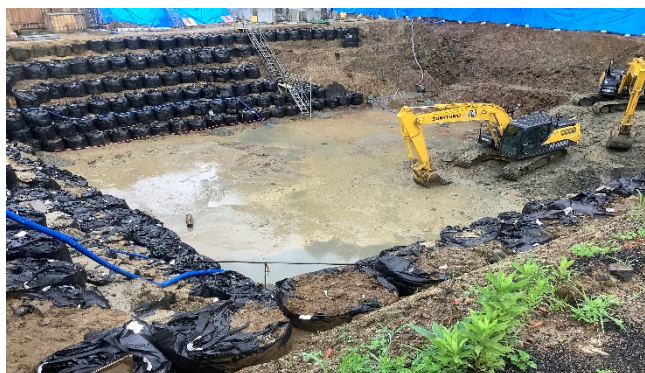
【写真①】掘削作業
