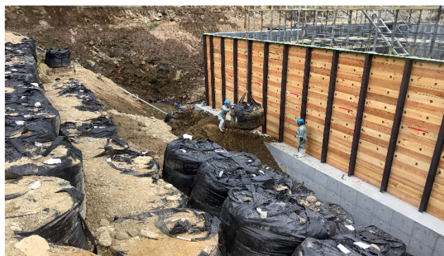
【写真②】大型土のう撤去・埋戻し作業
