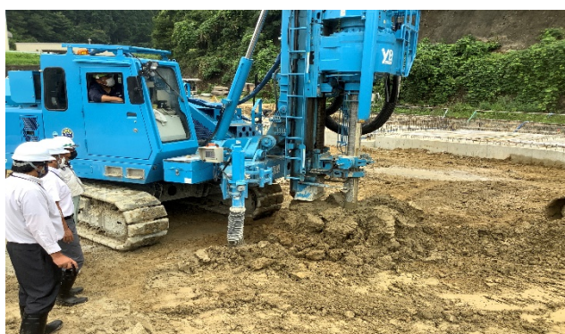
【写真①】改良杭構築作業
