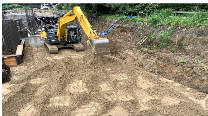
【写真②】埋戻し作業
