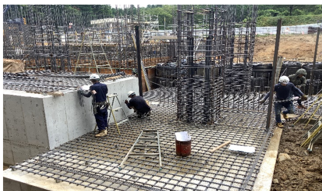
【写真③】鉄筋組み立て作業
