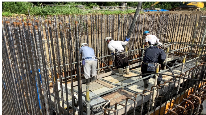
【写真④】ごみピットコンクリート打設作業
