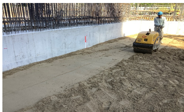
【写真②】埋戻し・転圧作業
