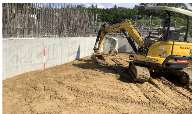
【写真①】埋戻し・敷き均し作業
