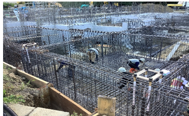
【写真④】鉄筋組み立て作業
