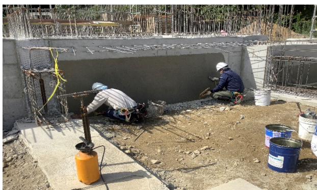
【写真③】塗布防水作業
