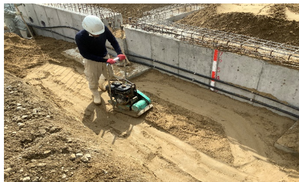
【写真②】埋戻土転圧作業
