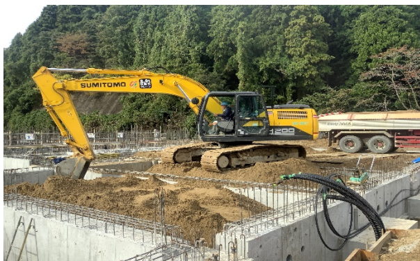
【写真①】埋戻し・敷き均し作業
