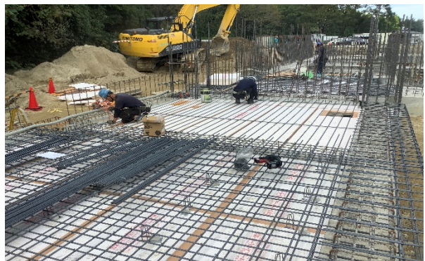
【写真③】鉄筋組み立て作業
