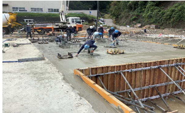
【写真④】耐圧盤コンクリート打設作業
