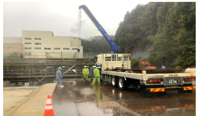
【写真②】鉄板敷き作業
