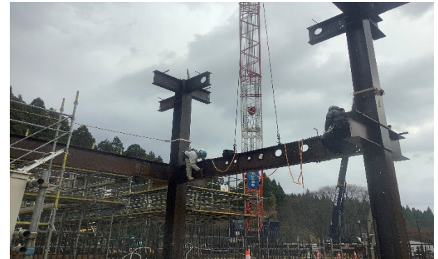
【写真④】鉄骨建方作業
