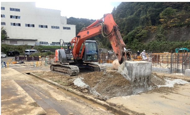
【写真①】表層地盤改良作業
