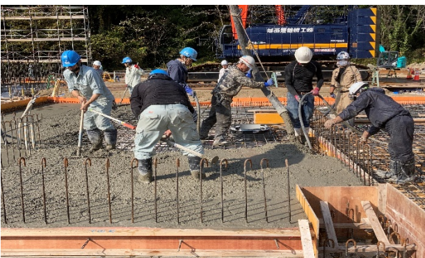
【写真③】土間コンクリート打設作業
