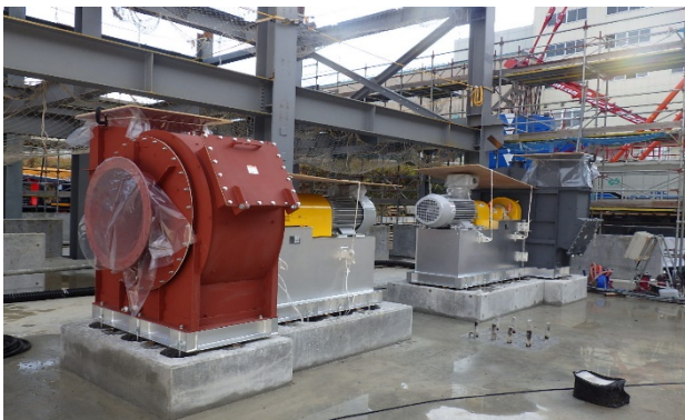
【写真③】1階機械取込状況
