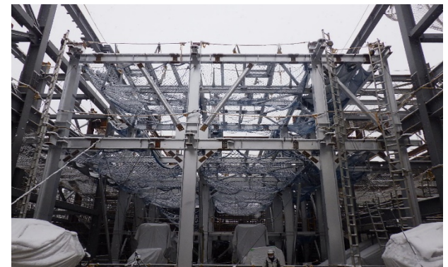
【写真④】炉室プラント架構建方状況
