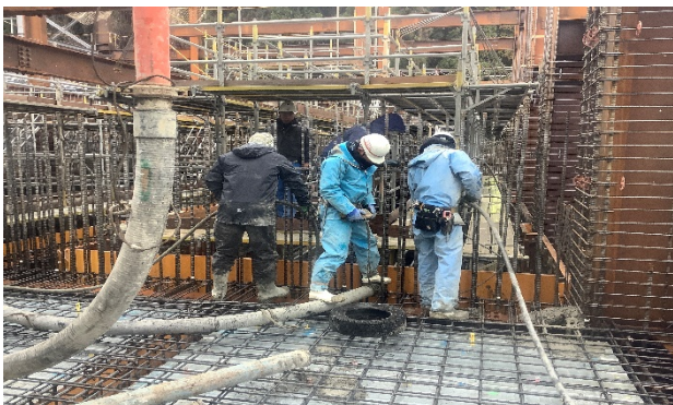
【写真①】1階躯体コンクリート打設状況
