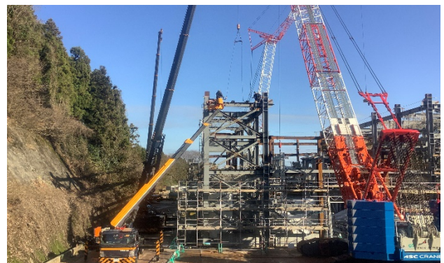
【写真②】電気室鉄骨建方状況
