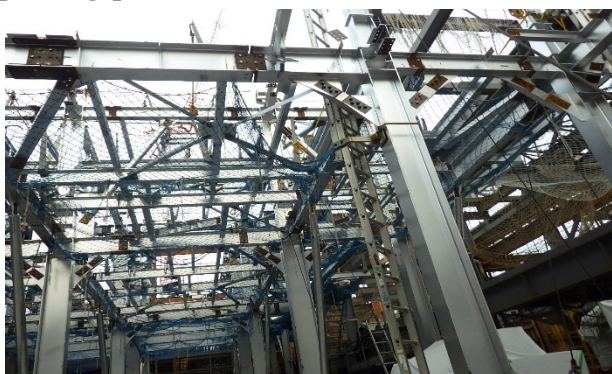
【写真③】プラント架構建方
