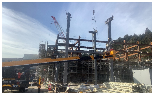
【写真②】プラットホーム鉄骨建方状況
