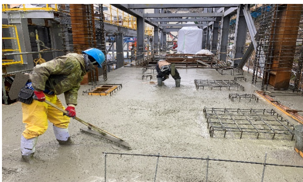
【写真①】2階躯体コンクリート打設状況
