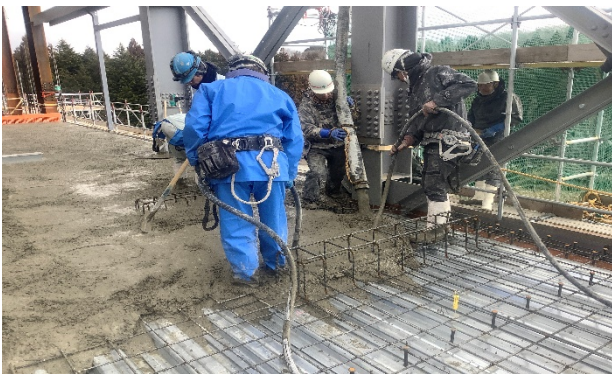
【写真①】4階デッキコンクリート打設状況
