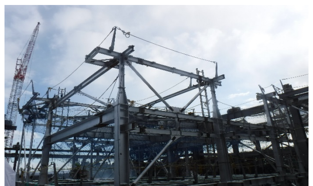
【写真④】プラント架構第2節建方状況
