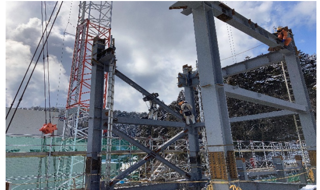
【写真②】灰処理エリア第3節鉄骨建方状況
