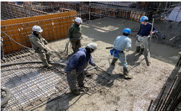
【写真①】4階躯体コンクリート打設状況
