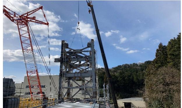
【写真②】電気室 鉄骨組立状況
