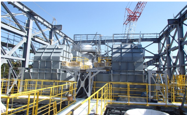
【写真③】空気加熱器組立
