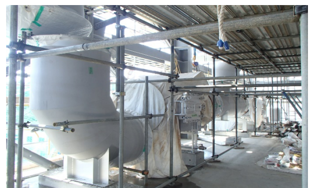
【写真④】ダクト仮組み
