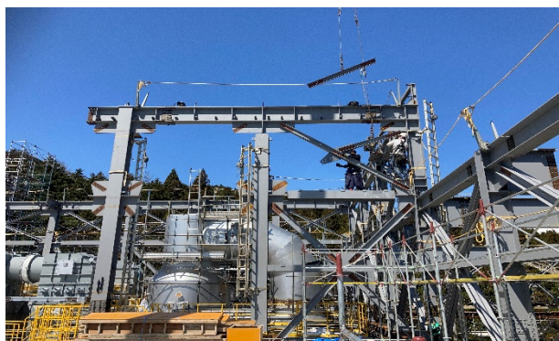
【写真①】 灰処理エリア鉄骨組立状況
