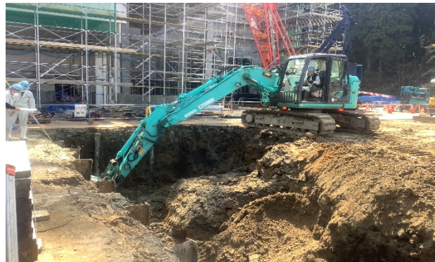
【写真②】 エントランス棟地中基礎掘削状況
