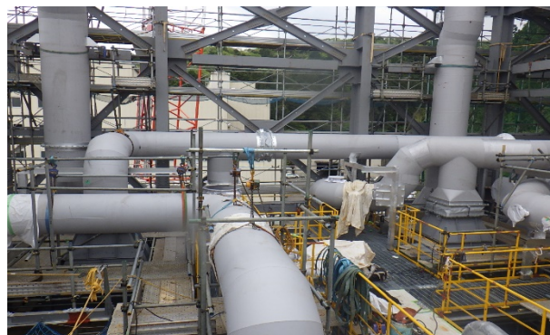
【写真④】 ダクト仮組み
