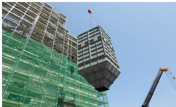
【写真③】 触媒分解塔取込み
