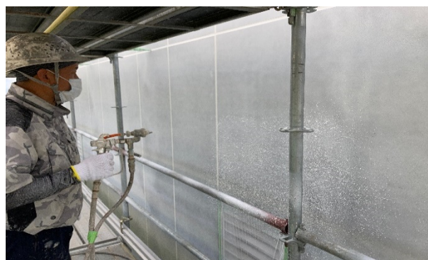
【写真②】外壁塗装吹付状況
