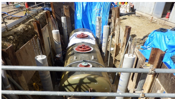
【写真③】助燃油貯留槽設置
