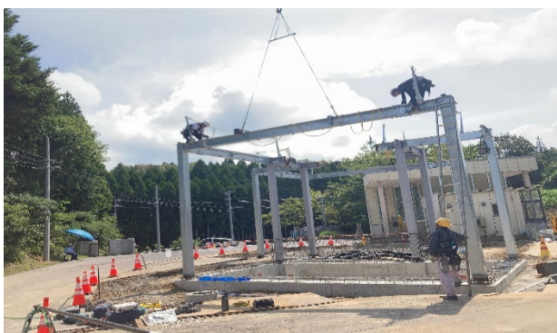
【写真①】計量棟鉄骨建方状況
