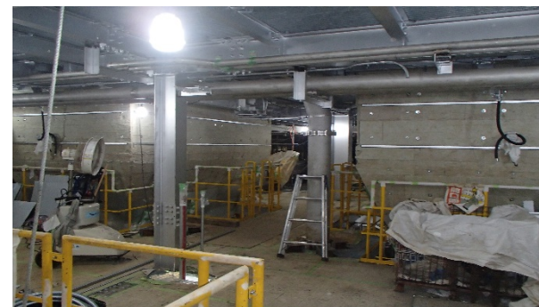
【写真④】機器保温工事
