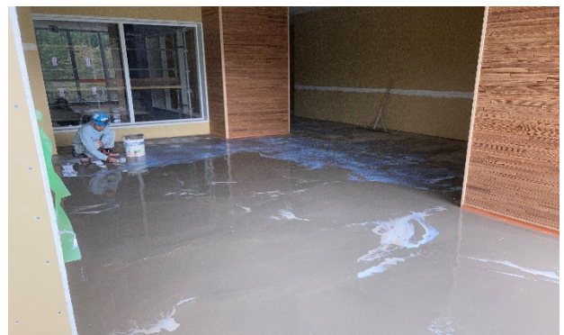
【写真②】床レベリング左官状況
