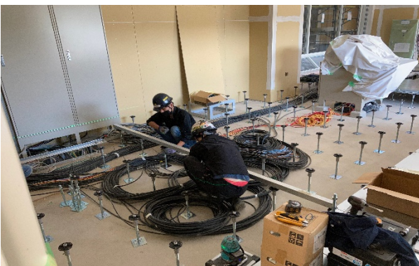
【写真①】OAフロア支持脚取付状況
