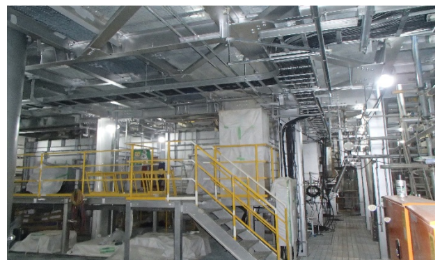
【写真④】機器保温工事
