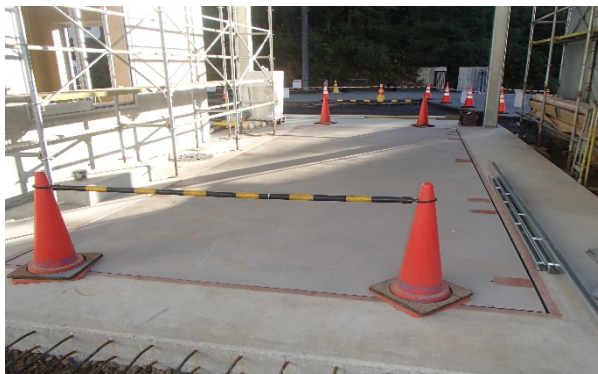
【写真③】計量機設置
