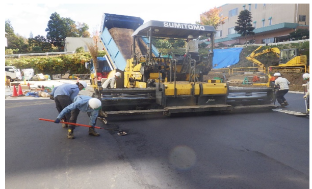
【写真②】アスファルト舗装状況
