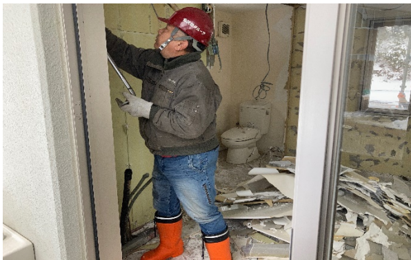
【写真①】旧計量棟 内装解体状況
