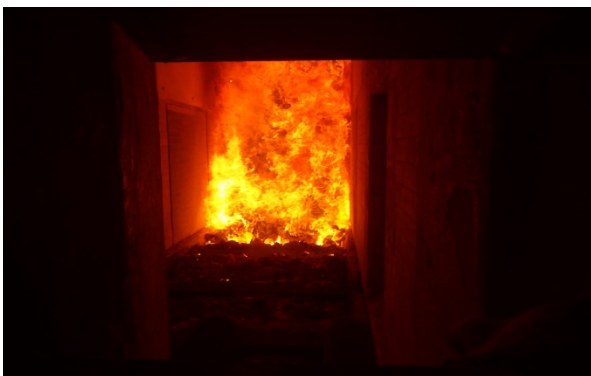
【写真③】2号炉焼却運転
