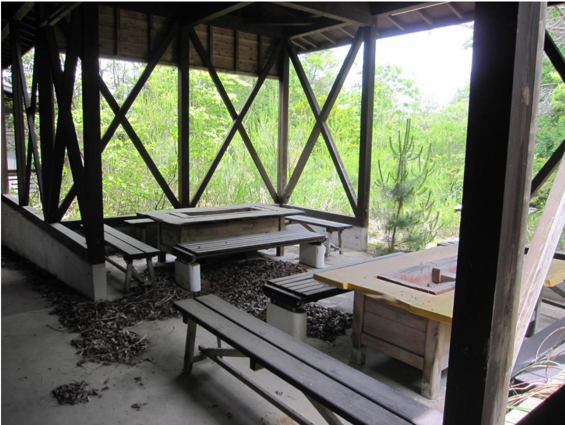
研修棟バーベキュー施設
