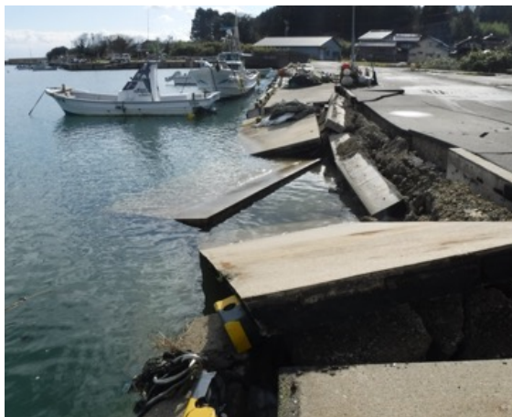
漁港 | 舗装・岸壁破損(左:中島町瀬嵐、右:能登島野崎町)
