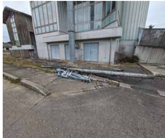
なかじま猿田彦温泉いやしの湯 電柱倒壊 (中島町小牧)
