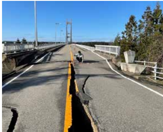
中能登農道橋 | 橋損傷・舗装亀裂(能登島通町～中島町長浦)
