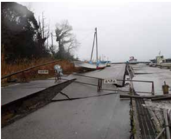
漁港 | 舗装・岸壁破損(左:中島町瀬嵐、右:能登島野崎町)
