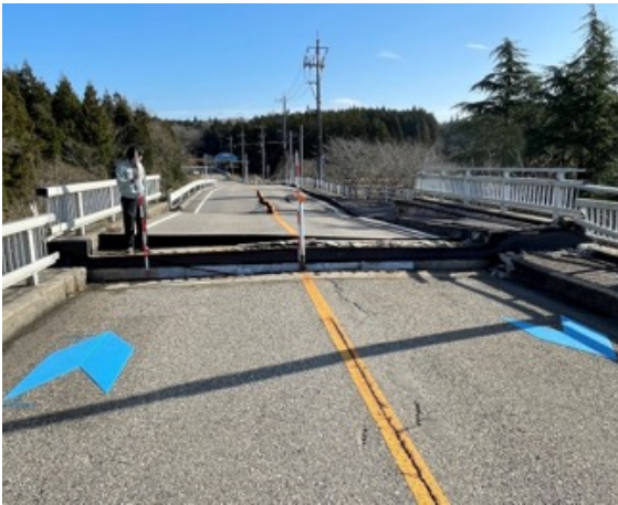
中能登農道橋 | 橋損傷・舗装亀裂(能登島通町～中島町長浦)
