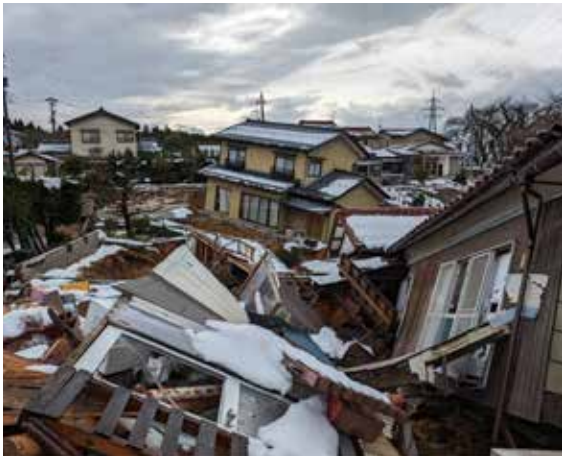
地滑り | 家屋倒壊・道路損傷(左:南ヶ丘町、右:藤橋町)
