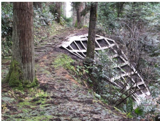
県指定史跡 赤蔵山被害修復状況写真
