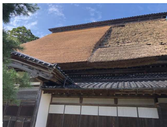
改修中の茅葺屋根（西側）
