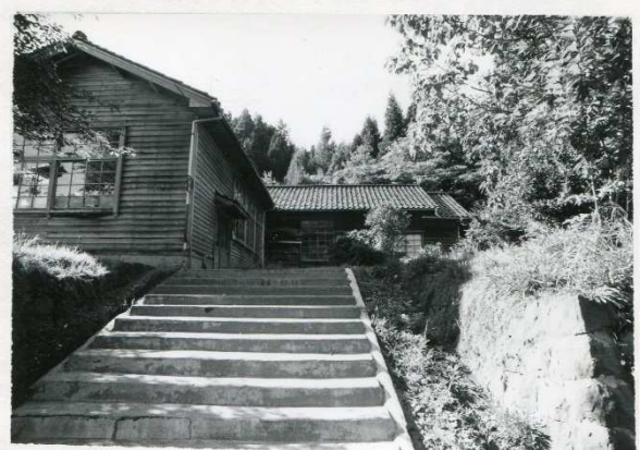
別所小学校跡地 (別所分校校舎) 創立は不明だが明治10年以前と推定される 現校舎は昭和22年3月新築、27年11月増築
