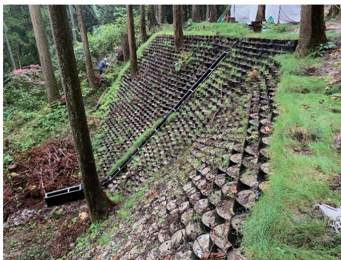
図 3-18 調度丸北側の法面安定化(令和元年度実施)
