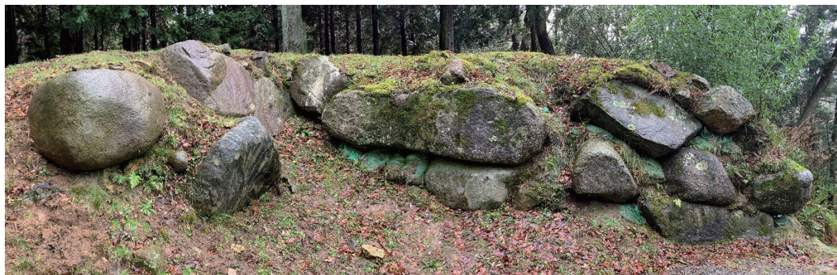
図3-19 石垣面の歪みにより築石の合端が開きつつある九尺石(2020年1月撮影)
