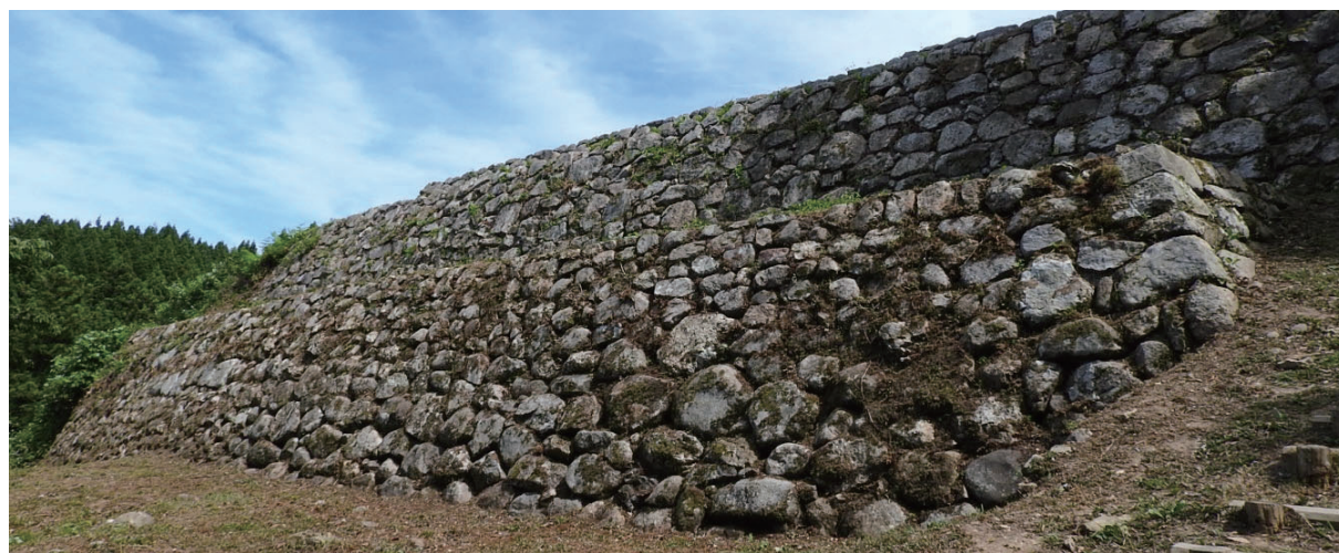
図3-20 切り石加工の石材を補填、モルタル詰め仕様の仕様で再修理された本丸北側石垣(2018年7月撮影)
