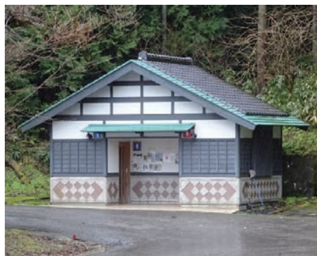
図 3-26 本丸駐車場近くにある便所
