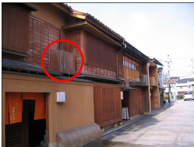
■ 室外機を目隠しした例
