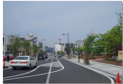
国道 249 号（市役所前交差点）
