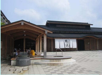
和倉温泉総湯の改修
