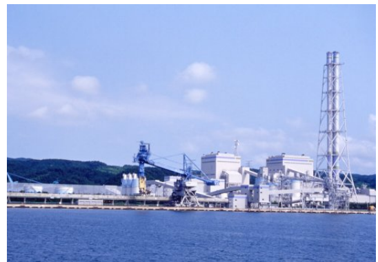
七尾大田火力発電所
